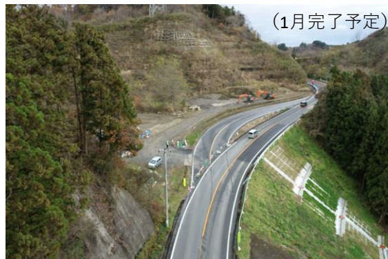
復旧工事中（10月末の状況）
