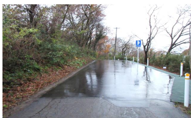
完了（10月（8箇所中6箇所完了））
