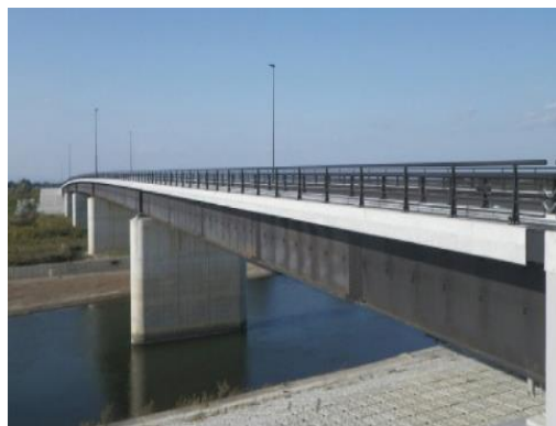
志田橋架設完成状況
