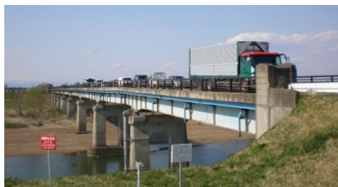
(旧志田橋)通行状況
