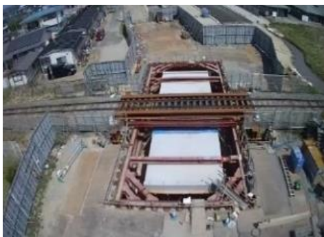
JR陸羽東線との交差部の函渠工施工状況
