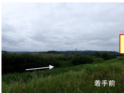
支障木伐採状況 (一級河川北上川水系出来川:涌谷町)
