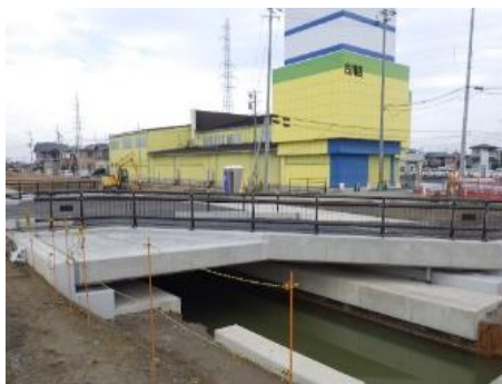
国道347号橋梁の完成状況
