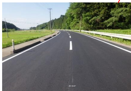
(主)利府松山線 大崎市松山下伊場野地内
