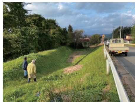
国道と河川堤防
