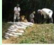
漏水箇所の補修
