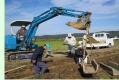
コンクリート水路の更新
