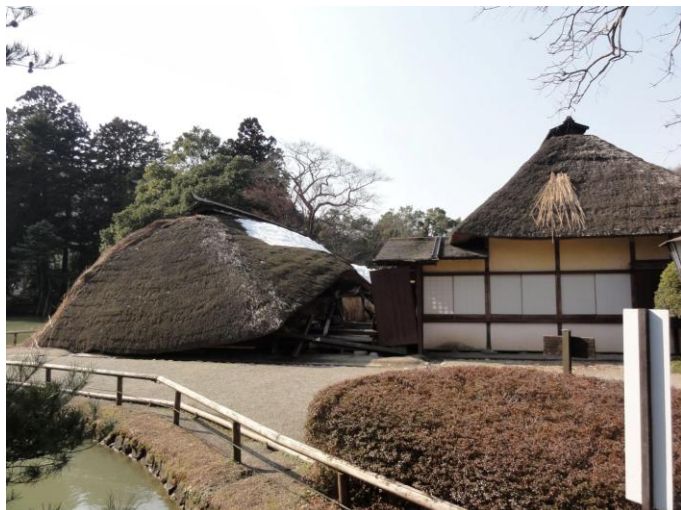
主屋の倒壊、付属屋の茅抜け落ち（ほか池護岸の地割れ など）
