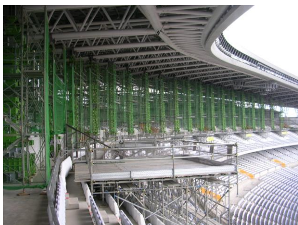
宮城スタジアム大屋根の補修
