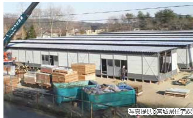
▲ 自治体による応急仮設住宅の建設作業
