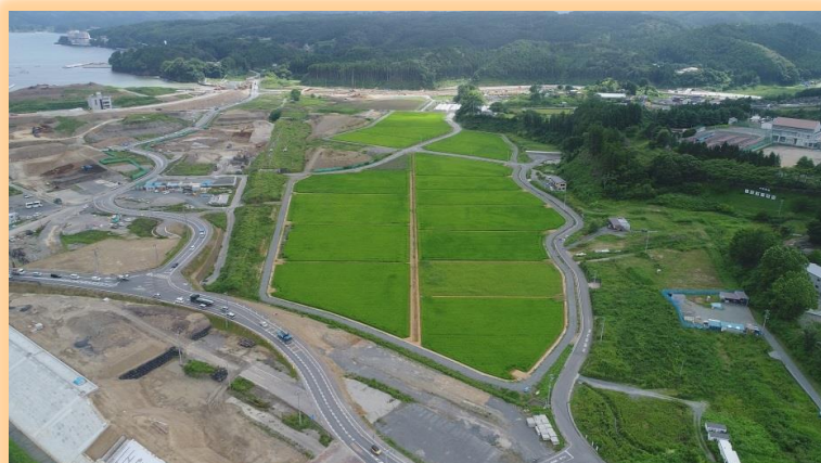
廻館工区 水稻作付状況
