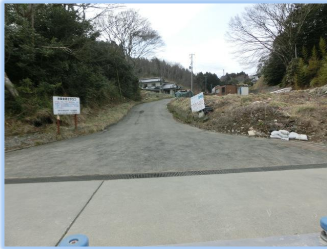
海岸堤防復旧：清水（1）地区（南三陸町）
