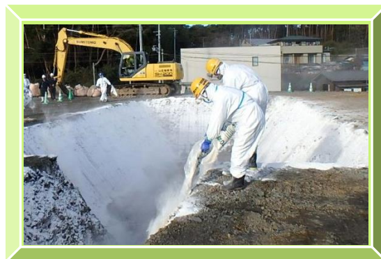
石灰の散布作業 (H30. 10. 31 撮影)
