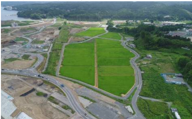
廻館工区 水稲作付状況
