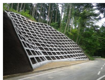
志津川登米線 入谷地内 完成状況
