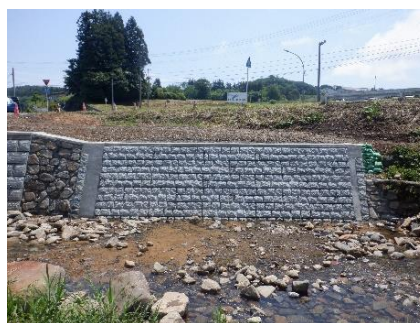
赤岩迎前田地内の完成状況
