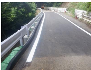
馬籠志津川線 弘川地内 完成状況
