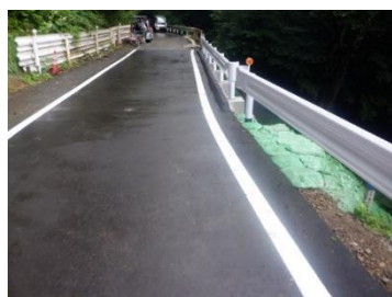
馬籠志津川線 午王野沢地内 完成状況
