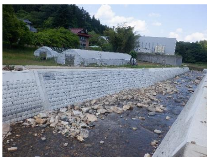
赤岩四十二地内の完成状況
