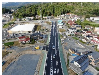
国道45号接続付近の状況
