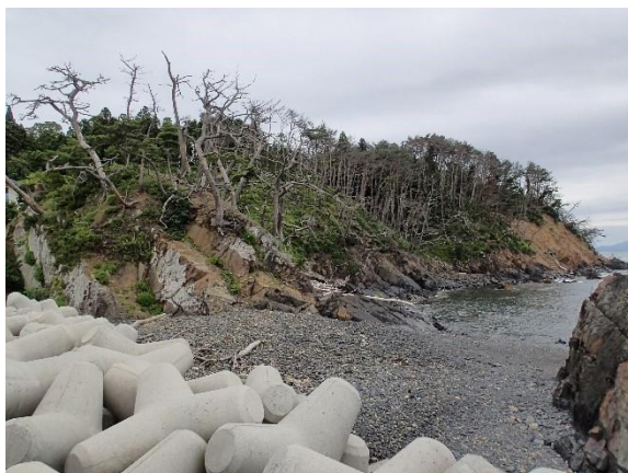
尾崎着手前状況
