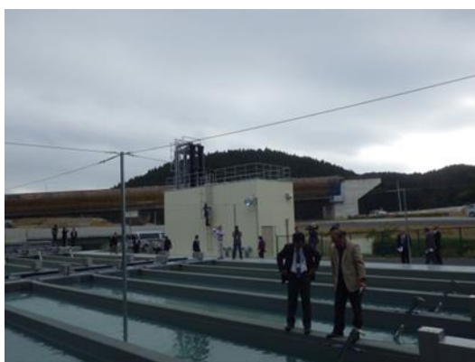
(完成した小森ふ化場)
