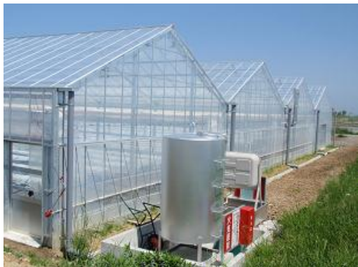
(鉄骨ハウスが立ち並びました)
