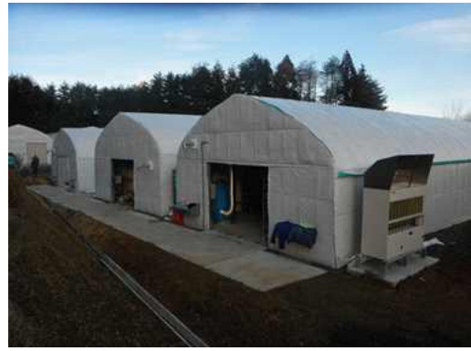
(完成した菌床しいたけ生産施設)
