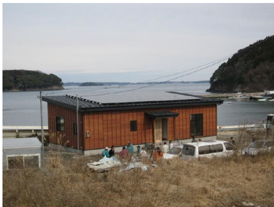
（事務所の屋根に設置されたソーラーパネル）
