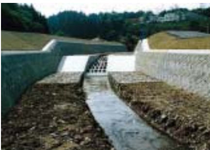
外尾川が改修された様子
