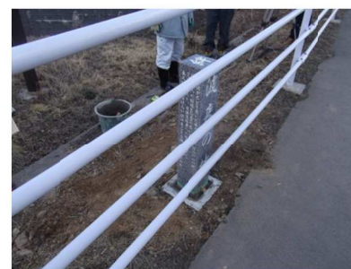
【石碑設置完了状況】
