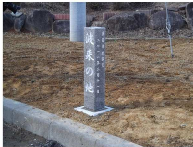
【石碑設置完了状況】
