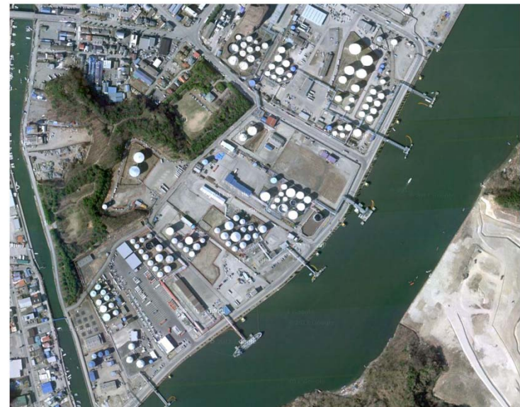
塩釜港区(塩釜油槽所)【震災後】
