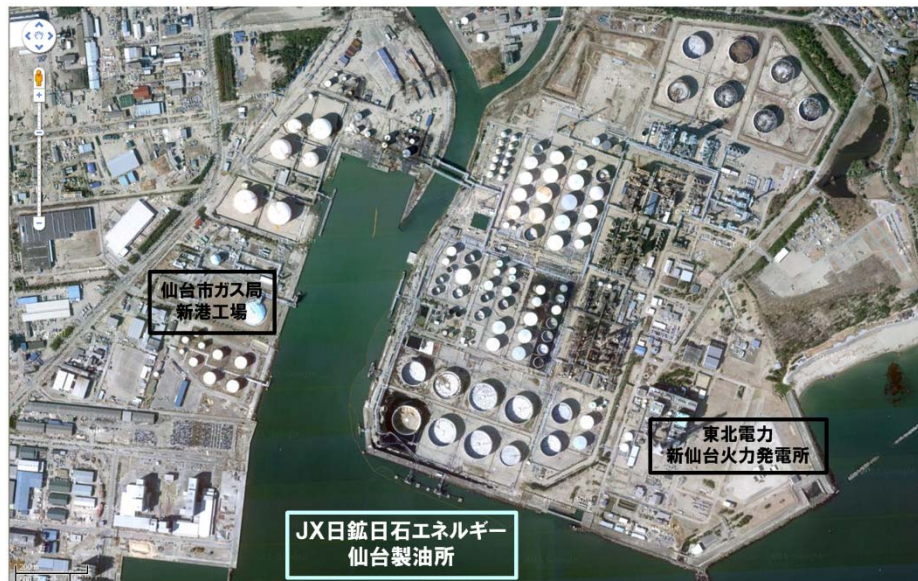
仙台港区(仙台製油所)【震災後】
