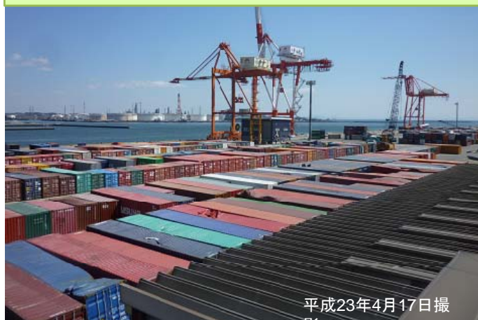
発災後約1ヶ月 コンテナの整理が進む
