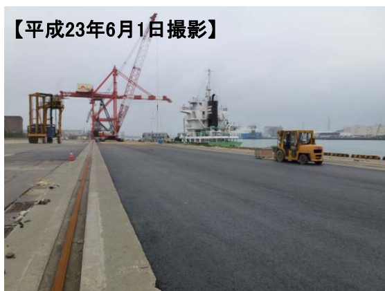
レール間の応急復旧舗装状況 高砂1号(-12m)
