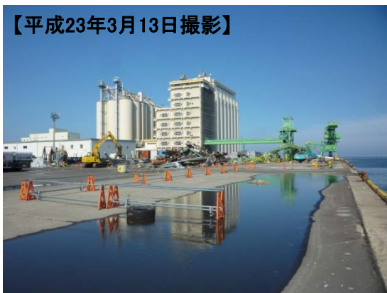
バリケード及び障害物等仮置き状況 中野1号(-12m)・2号(-10m)
