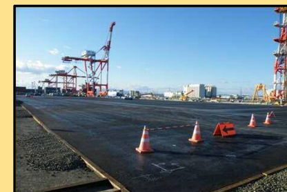
11月8日 高砂2号ふ頭の工事の様子
