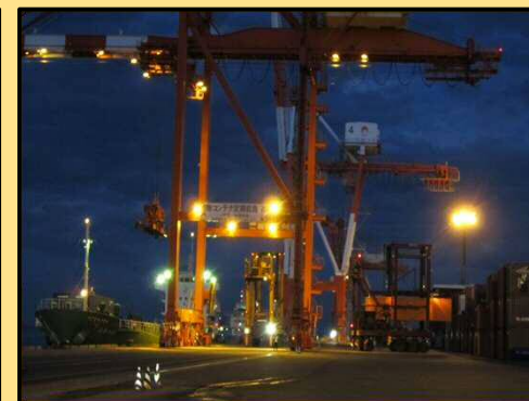
11月9日 夜間照明点灯中
