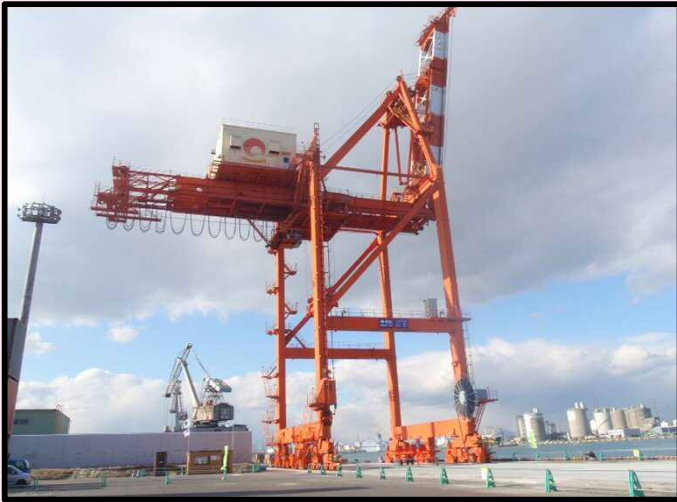
平成23年12月9日 ガントリークレーン1号機
