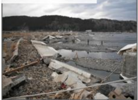
戸倉地区海岸被災状況
