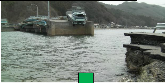
釜谷大須雄勝線(尾崎橋仮橋設置)
