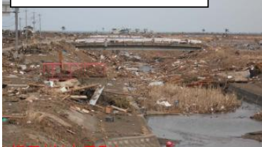
坂元川 瓦礫状況
