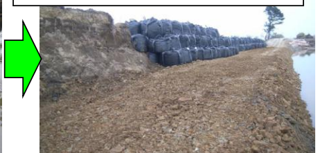
七北田川 大型土のうによる仮締切状況
