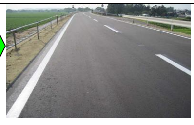
迫川 左岸堤防応急本工事完了
