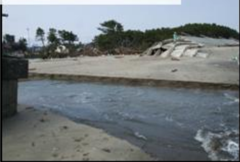
菖蒲田地区海岸被災状況
