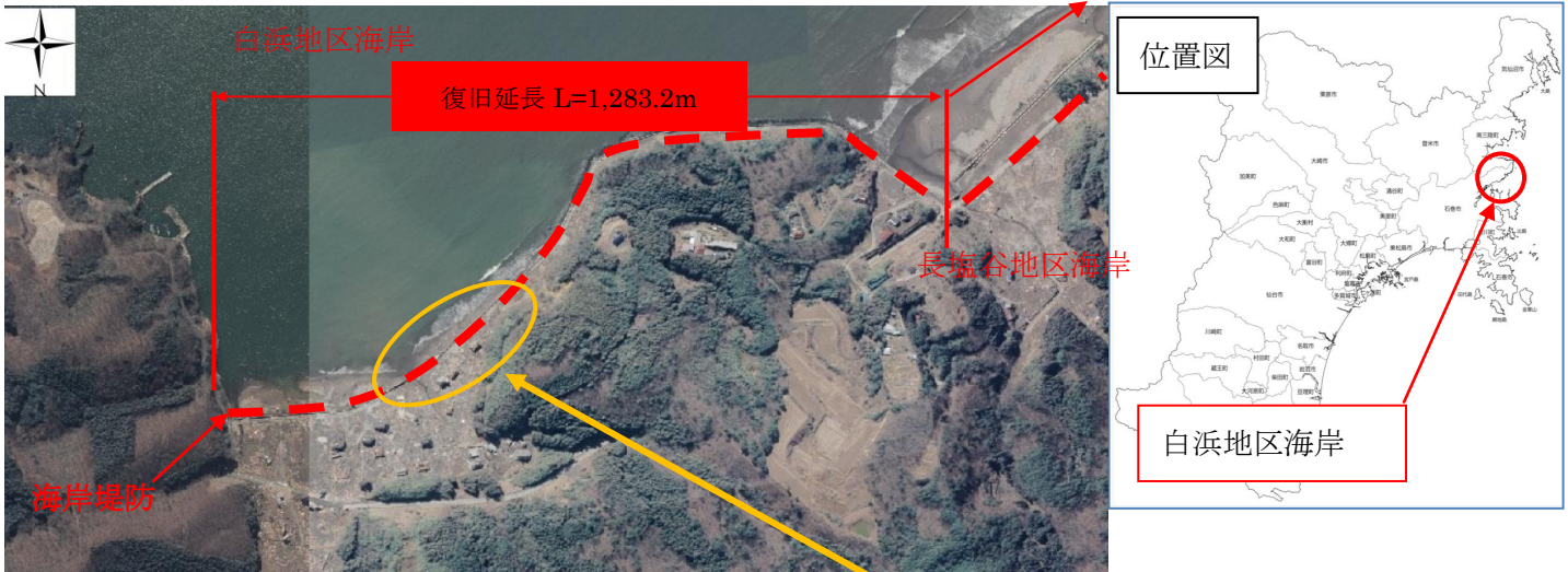
① 応急復旧 (H23年8月まで完了)
