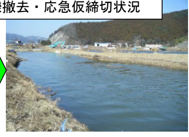
砂押川 仮堤防設置
