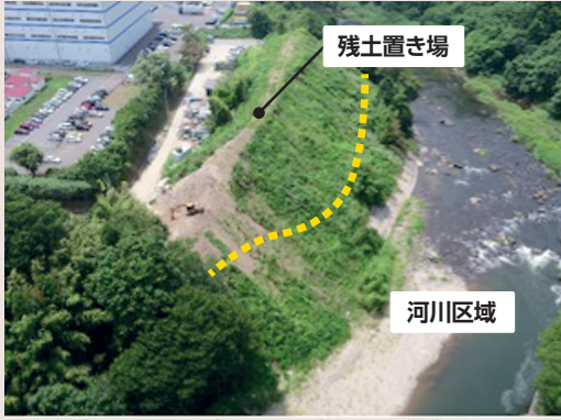
残土流出の状況
