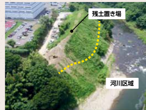
残土流出の状況
