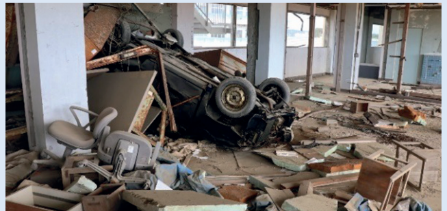
気仙沼市東日本大震災遺構伝承館
