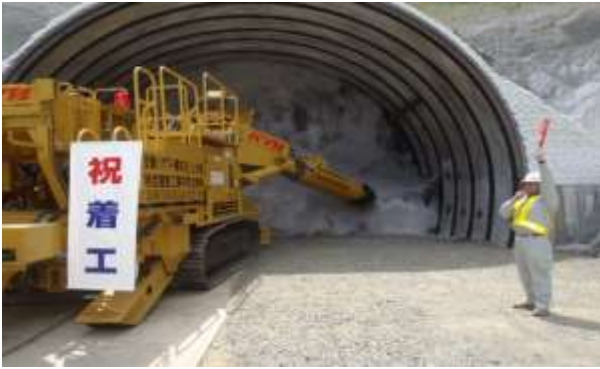
トンネル工事の着工の様子
