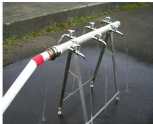
水道栓設置状況
