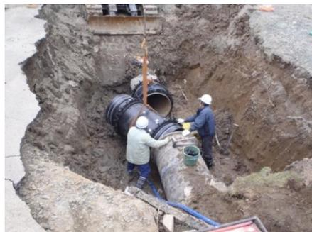
直管・継輪による復旧状況
