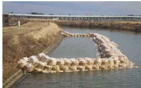
増田川 仮設沈殿池【写真】
