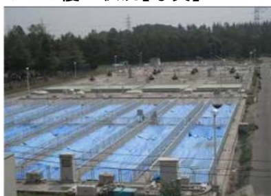
シート覆工状況【写真】
