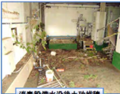
消毒設備水没後土砂堆積
