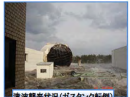
津波襲来状況(ガスタンク転倒)
