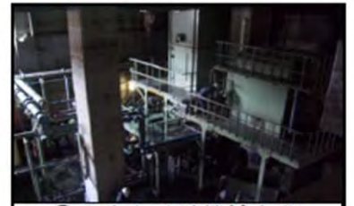
①沈砂池(沈砂機械水没)
