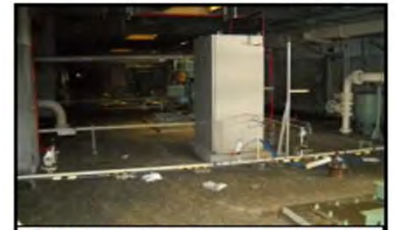
③反応タンク1・2系(浸水・泥堆積)
