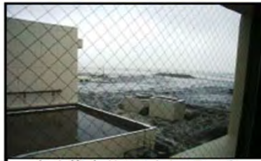
津波襲来状況(水処理3系)
