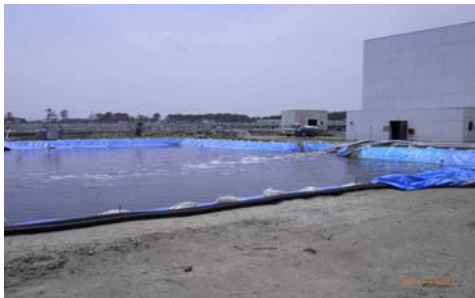
県南浄化センター 仮設沈殿池【写真】
