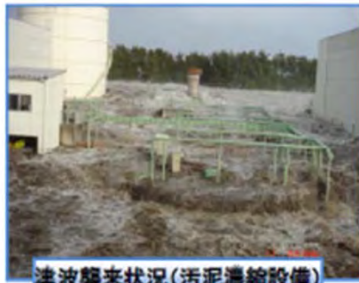
津波襲来状況(汚泥濃縮設備)
