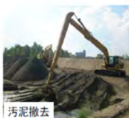
沈殿池撤去状況
