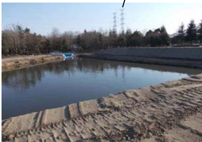
多賀城緩衝緑地公園内 仮設沈殿池【写真】
