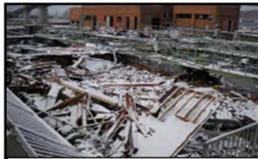
④最終沈殿池(水没)
