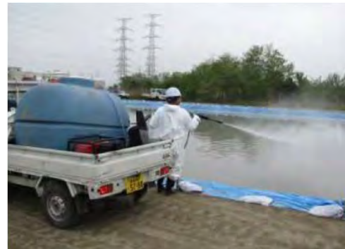
写真:消臭剤散布状況
