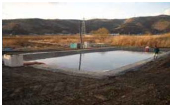
真野川 仮設沈殿池【写真】
