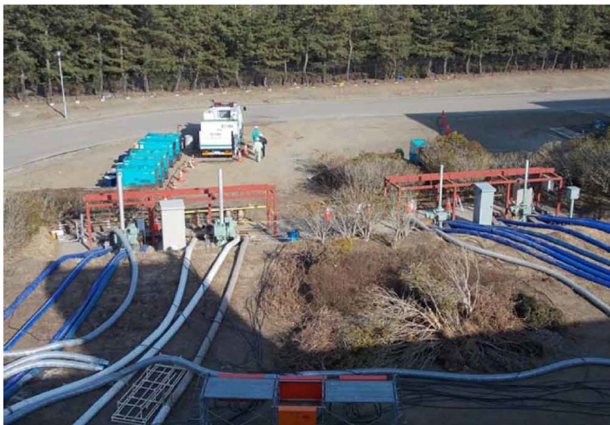
写真：仮設ポンプ設置状況（仙塩浄化センター）
