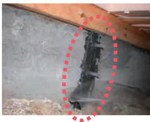
エポキシ樹脂による補修
