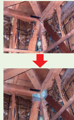
既存の筋かい端部を金物で補強
