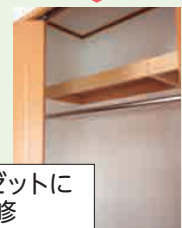
押入壁を合板で補強して
