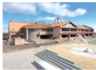
震災遺構中浜小学校 (山元町)
