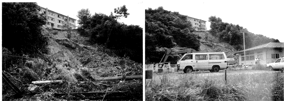
県営黒松第二団地（泉市黒松）北側法面崩壊
