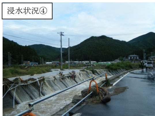
被災状況(コンクリート護岸基礎洗堀)⑥
