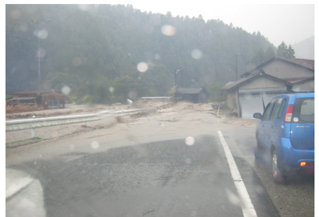
南沢川越水状況
