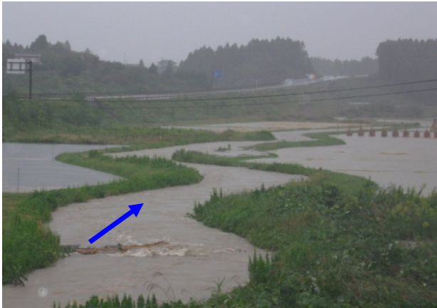
越水状況（栗原市築館赤坂地内）
