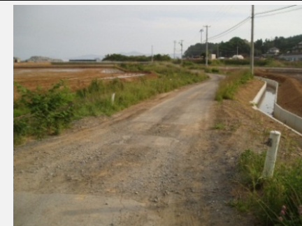
② 着手前 平成26年4月
