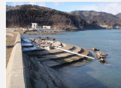
② 着手前 平成25年3月
