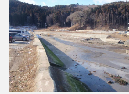
④ 着手前 平成25年3月
