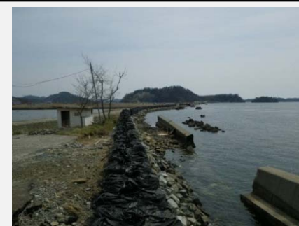
④ 着手前 平成25年4月
