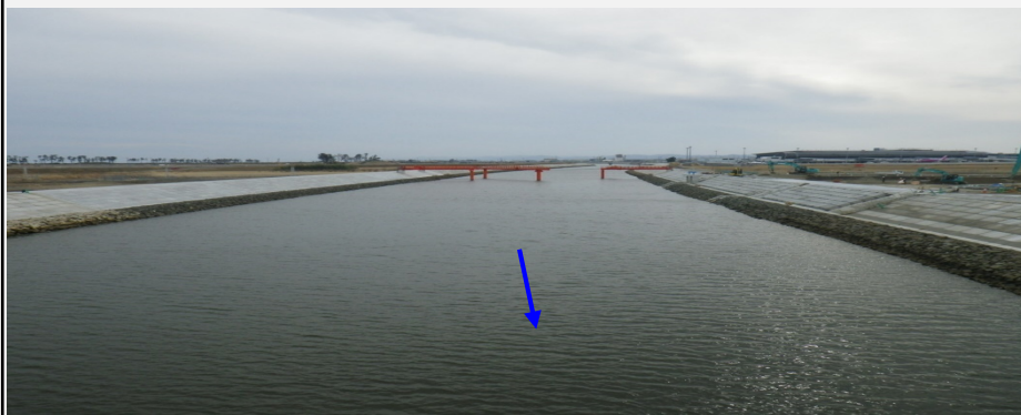
新しい堤防が完成しました(上流部)。
