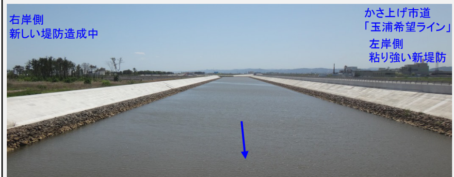
新しい堤防が完成しました(上流部)。
