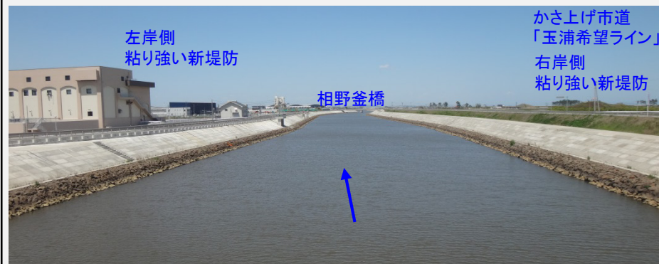
新堤防が完成し、玉浦希望ラインも開通しました。
