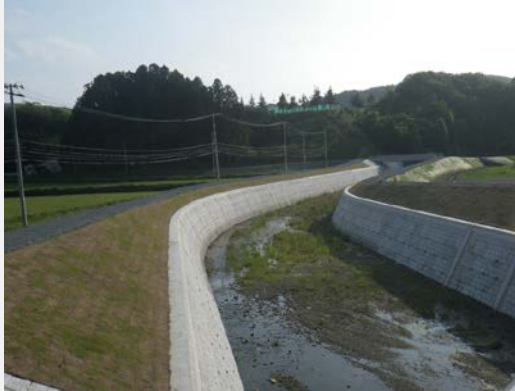
追場橋から上流の扇橋を望む。
