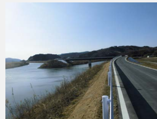
第二吉浜橋 完成しました。
