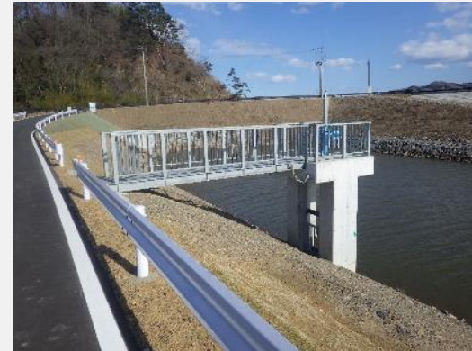
大沢川1号樋管の状況。
