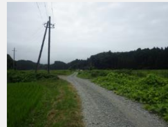
右岸 NO.40より下流方向撮影
