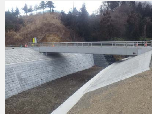
扇橋 完成しました。
