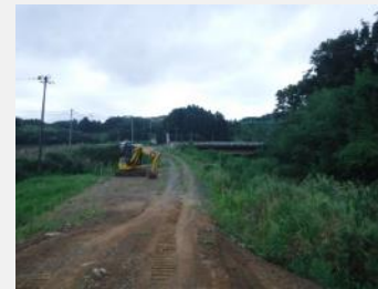
右岸 起点側より上流方向撮影
