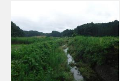
追場2号橋より下流方向撮影
