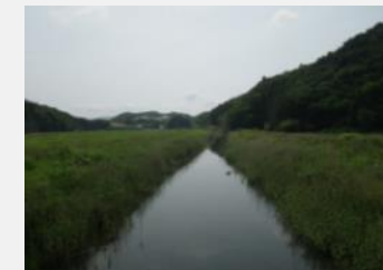
着工前 追波沢川(NO.17よりNO.28方向撮影)
