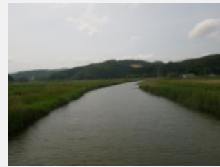
着工前 追波沢川(NO.2よりNO.7方向撮影)
