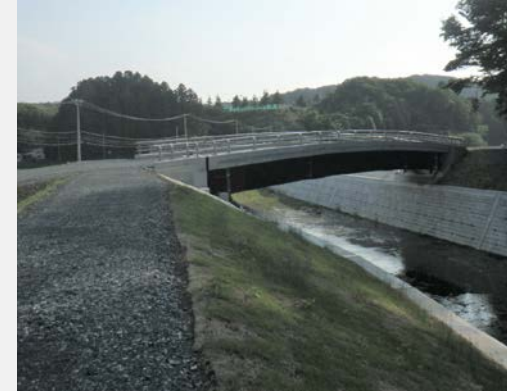
工事起点右岸から上流を望む。
