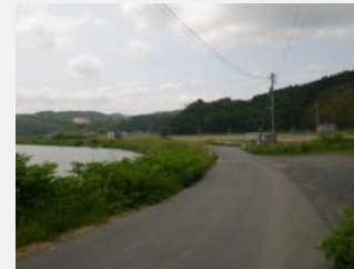
着工前 大沢川(起点側よりNO.3方向撮影)
