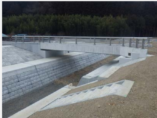
追場2号橋 完成しました。
