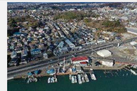
④ 着手前 令和2年2月
