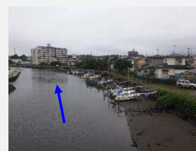
④ 着手前 令和元年7月
