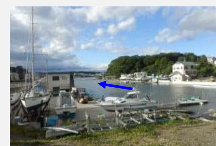
④ 着手前 平成27年3月
