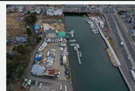
④ 着手前 令和2年2月
