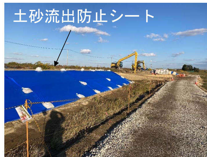
濁水防止措置 (名蓋川)
