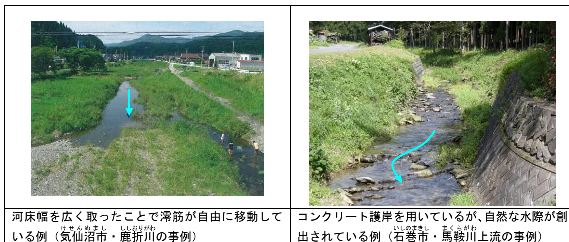
図 2-25 多自然川づくりの断面設定例
