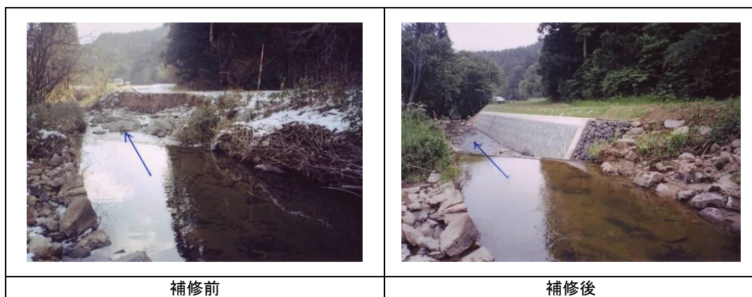
図 2-28 河道の維持管理（護岸の補修：小田川）
