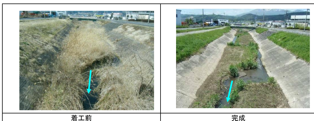
図 2-29 河道の維持管理（滯筋を残した堆積土砂撤去：白石市・大太郎川 しろいしし だいたろうがわ の事例）
