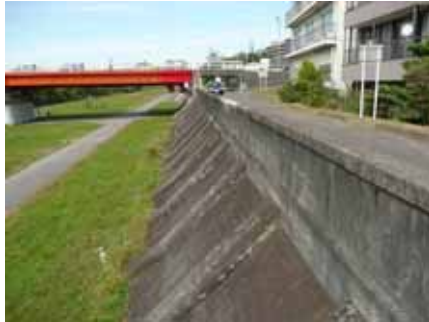
宮沢橋下流の特殊堤
