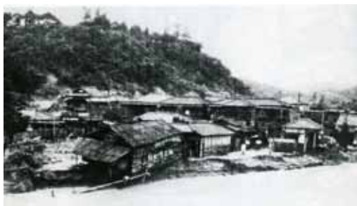
昭和25年8月洪水(広瀬川愛宕橋上流)
