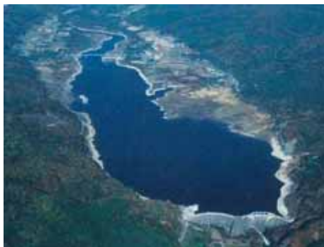
ダム湖周辺の状況
