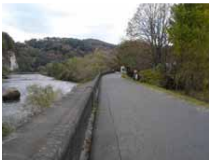
ひょうじょうがわらばし 評定河原橋上流の特殊堤
