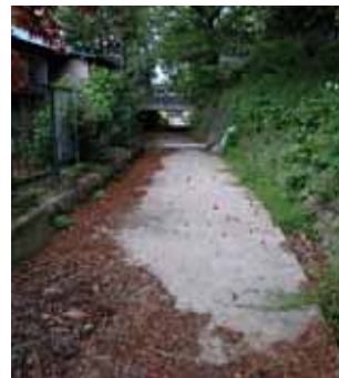
現存する四ッ谷用水(現在は覆蓋化)
