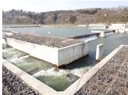
秋山頭首工(迫川)に設置された魚道
