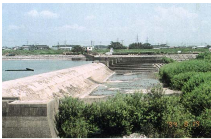
図 1-27 平成6年8月濁水時の上川原頭首工（鳴瀬川）
