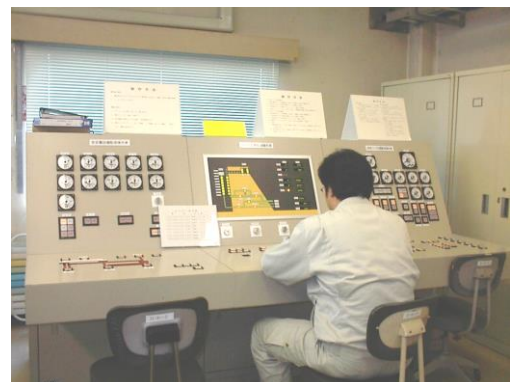
写真 2-10 樽水ダム保守点検
