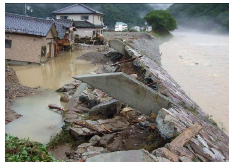
平成21年台風9号による被災（兵庫県佐用町）
