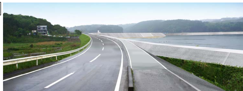
視点②海岸堤防背後の国道45号
