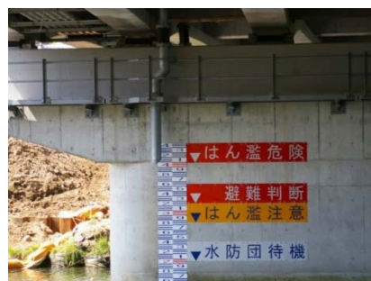
橋脚への水位表示例
